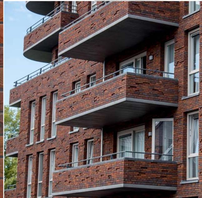
Deze handvormgevelsteen wordt vervaardigd van Lössleem, onder meer gewonnen uit het plateau van Kesselt in de Maasvallei (België) en opgewaardeerd met grondstoffen uit de Vulkaneifel.
